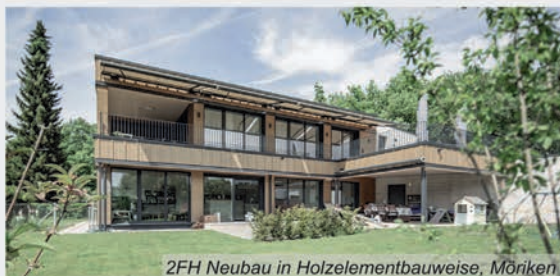
2FH Neubau in Holzelementbauweise, Mörken
