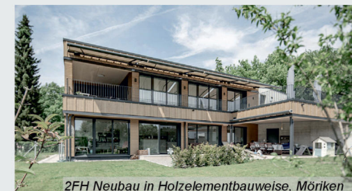
2FH Neubau in Holzelementbauweise, Möriken
